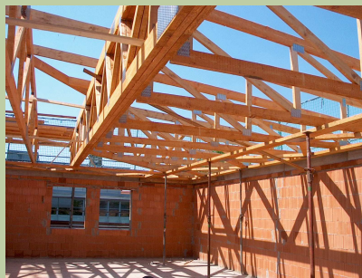
Detailansicht der Dachkonstruktion
