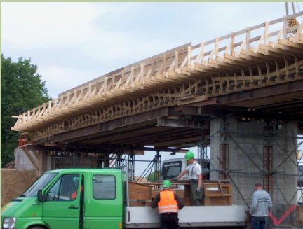
Seitenansicht der Schalung
