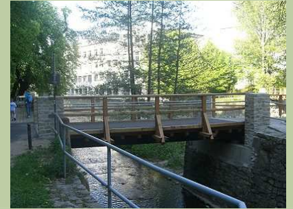
Brücke über den Kappelbach
