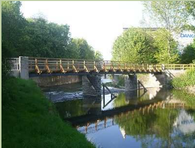
Brücke über die Chemnitz
